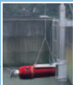
Installazione di miscelatore sommerso tipo MX-GIR. Installation of a submersible mixer type MX-GIR.
