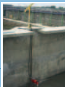
Installazione di miscelatore sommerso tipo MX-GIR con struttura di sollevamento. Installation of a submersible mixer type MX-GIR with lifting system.
