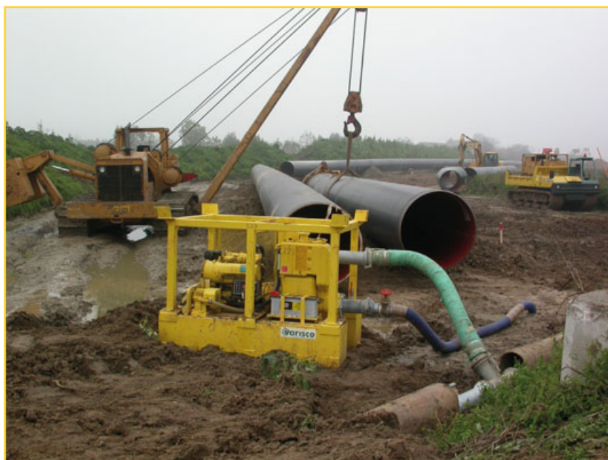
Drenaggio scavi per posa metanodotto Drainage excavation for pipeline installation Drenaje de las excavaciones para puesta metanoducto
